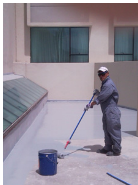
Aplicación Kubal Coat con rodillo en losas de techo.
