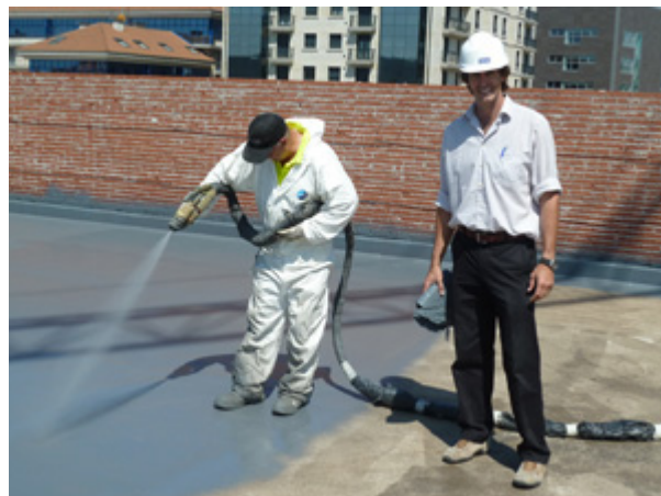
Aplicación de Hyperdesmo HC con pistola en losas de techo.
